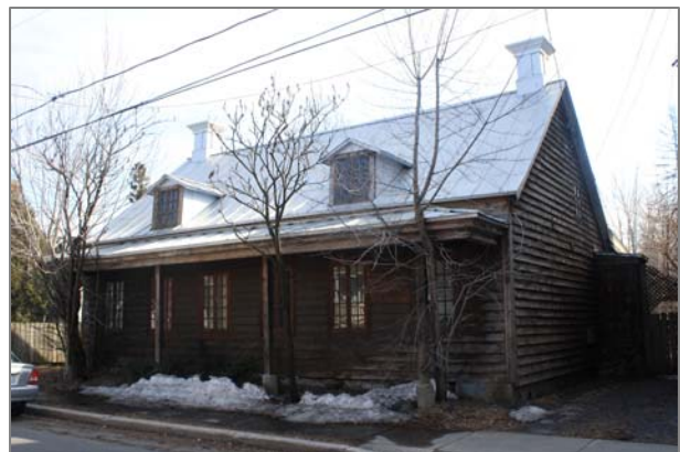
Maison voisine, au nord, du 226-228, rue Grant. Issue de la même époque, cette maison a conservé sa toiture et ses cheminées en tôle traditionnelle.
