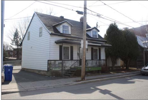
La maison du 226-228, rue Grant qui a conservé les caractéristiques essentielles de son modèle architectural : volume, forme de la toiture, lucarnes, disposition des ouvertures en façade, galerie couverte.
