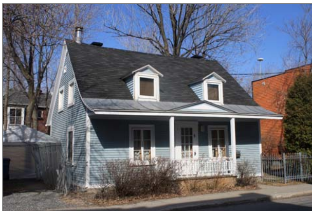
Maison de même type située tout près, au 205, rue Grant, qui possède des caractéristiques semblables. Cela démontre le potentiel que revêt le 226-228, rue Grant.
